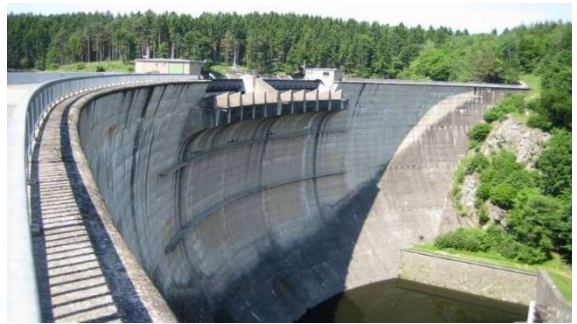
Abb 2: Staumauer Ottenstein, Foto G. Petritsch
